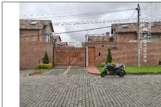
Foto No. 1. Fachada Conjunto Residencial Teruel.
