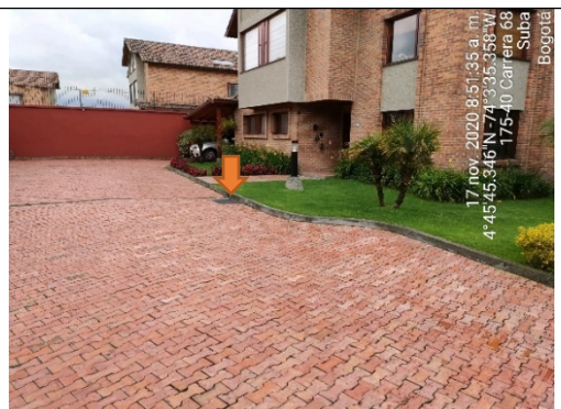
Foto No. 6. Sumideros pluviales – sistema de evacuación de ALL Conjunto Residencial Teruel.
