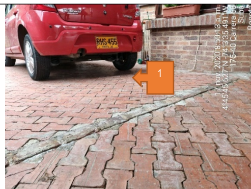
Foto No. 4. Área de ubicación de la unidad separadora de grasas (TG) casa No. 1. (no pudo verificarse en visita)
